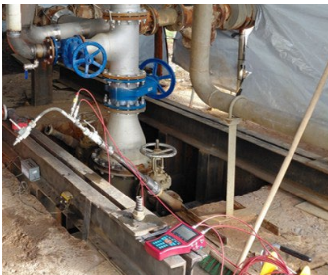
Obr. 8 Instrumentace tlaková zkoušky Fig. 8 Pressure test instrumentation
