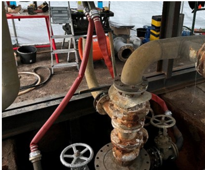
Obr. 5 Rekonstruovaný odlehčovací kříž a napojení bypassů Fig. 5 Wellhead cross and bypass connection
