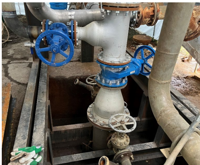
Obr. 7 Zrekonstruované zhlaví vrtu Fig. 7 Wellhead after reconstruction
