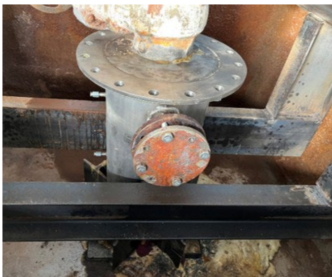
Obr. 4 Stabilizované zhlaví vrtu
