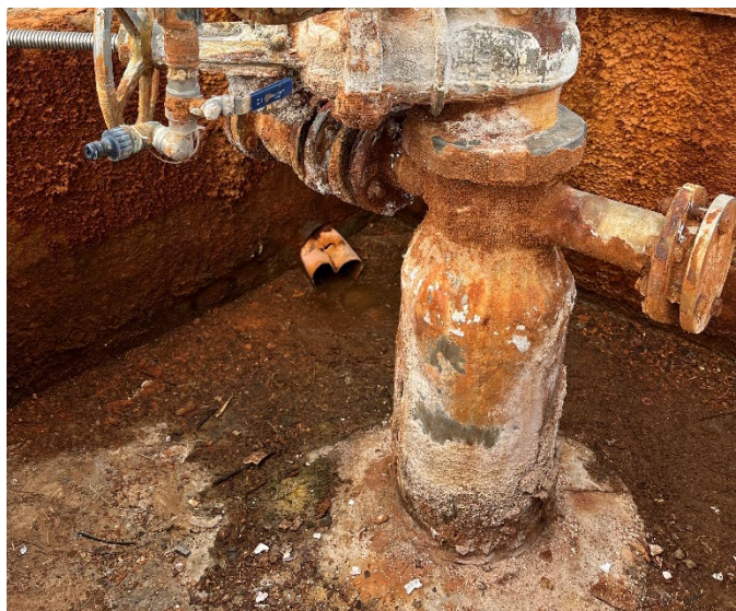
Obr. 3 Zhlaví vrtu před rekonstrukcí
